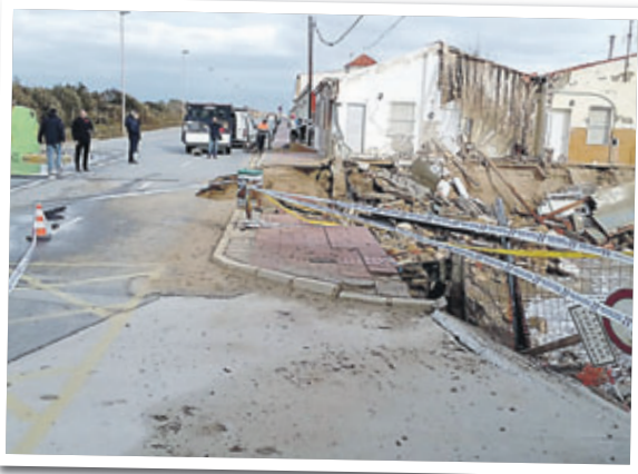
COLLAPSED HOUSES: In Guardamar del Segura.
