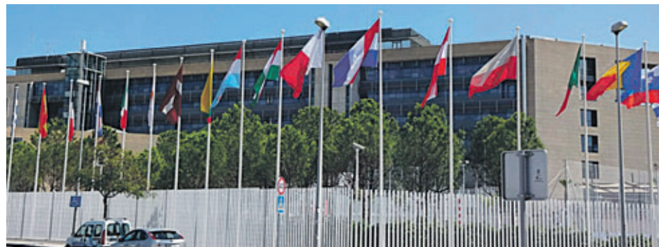
EQUIPO AWARD: The extension building of EQUIPO in Alicante is up for a sustainability award.
